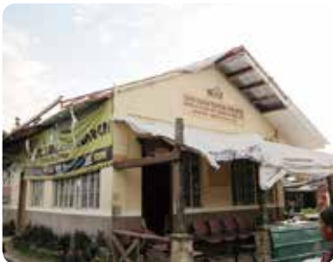
Gawad Kalinga Development Foundation, Inc. のオフィスも被害を受けた
