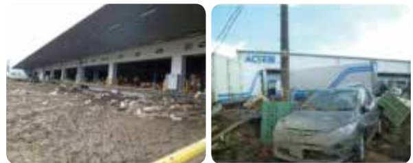
被災直後の仙台低温物流センターと周辺の状況
