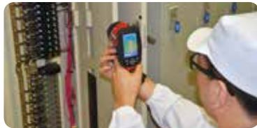
サーモグラフィーを使って配電盤の異常を早期に発見
