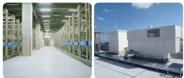
新倉庫内部の様子
